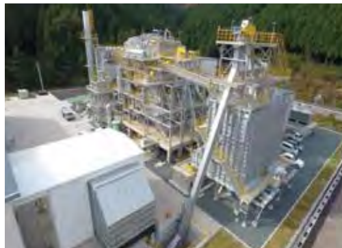
朝来バイオマス発電所
