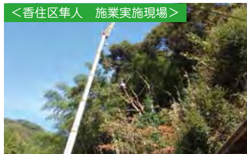
クレーンを用いた人家裏山の危険木伐採
