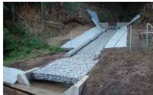
人家裏山の簡易防災施設の設置
